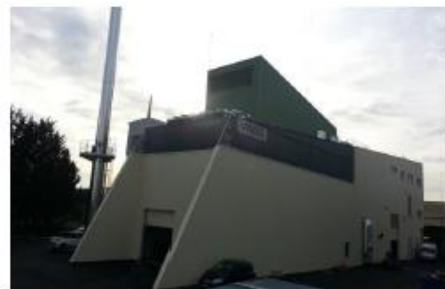
Centrale biomasse de Labouheyre
