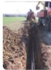
Enfouissement des câbles
