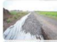
Revêtement de chemins d'accès
